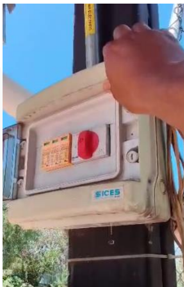
Centro de carga de corriente directa.
